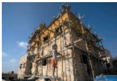
Case in costruzione
