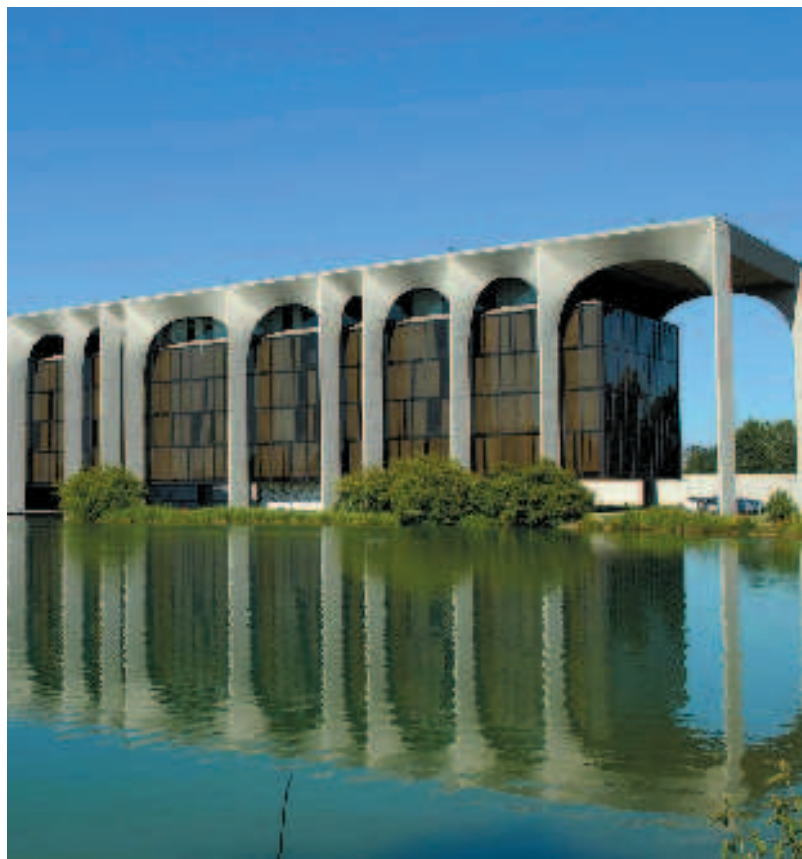
Una visuale esterna di Palazzo Mondadori a Segrate (Milano)
