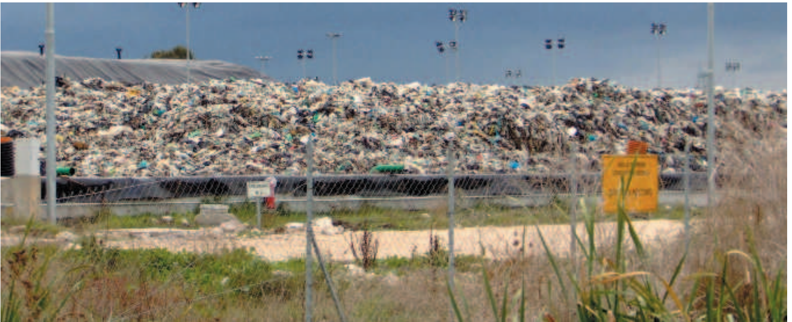
Ferrandelle Il sito di stoccaggio di Ferrandelle (Caserta) protetto dalle recinzioni militari
