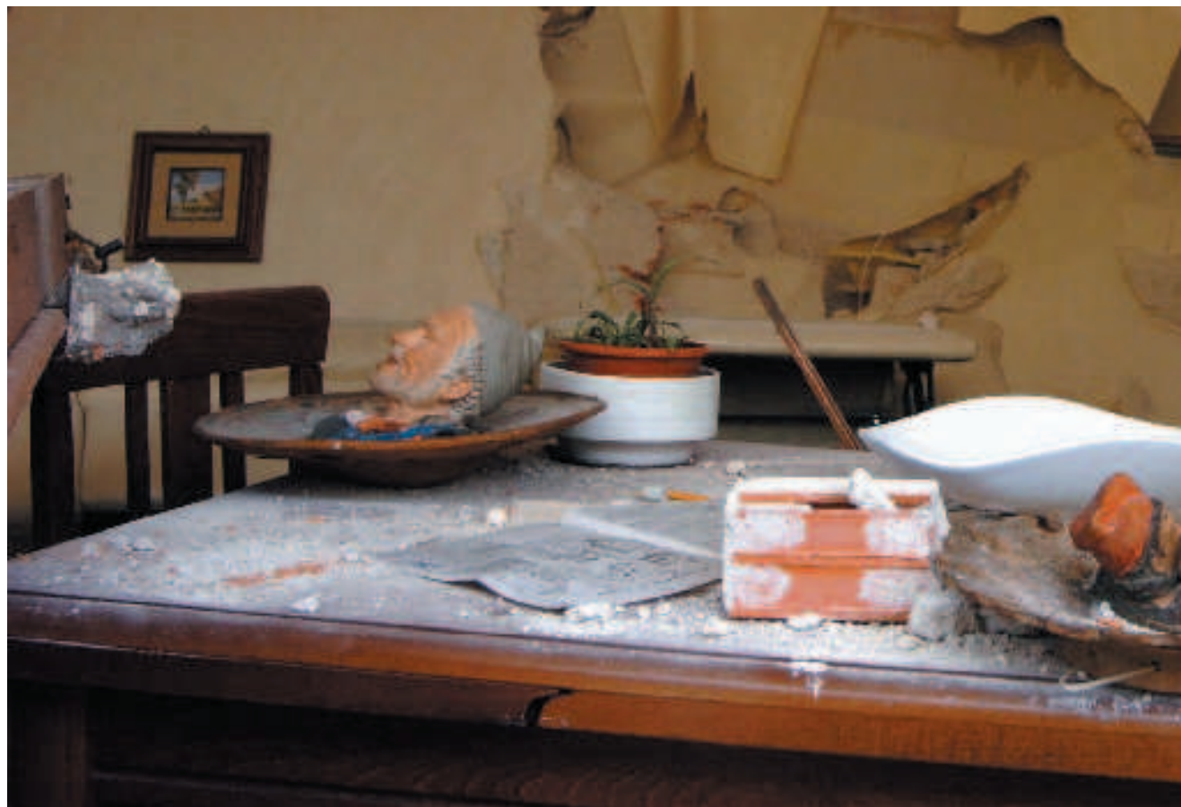
Interno abbandonato Un tavolo, pochi attrezzi in una casa pericolante. Nella foto a destra, la cupola crollata di Santa Maria del Suffragio
