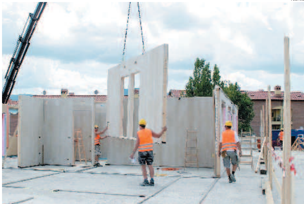
La costruzione di case prefabbricate vicino L'Aquila
