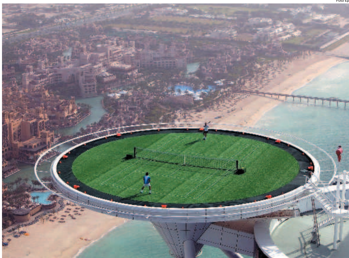
Il campo da tennis ricavato sull'elipporto sospeso del Burj Al Arab, il più lussuoso hotel del mondo situato a Dubai
