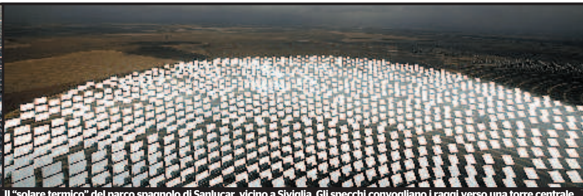
Il "solare termico" del parco spagnolo di Sanlúcar, vicino a Siviglia. Gli specchi convogliano i raggi verso una torre centrale
