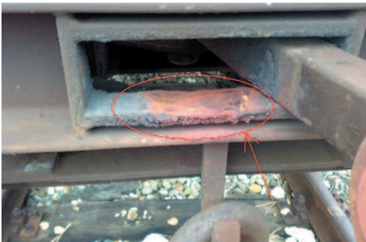
Una delle foto scattate dal sindacato che mostra una bocchetta di gancio da traino completamente usurata
