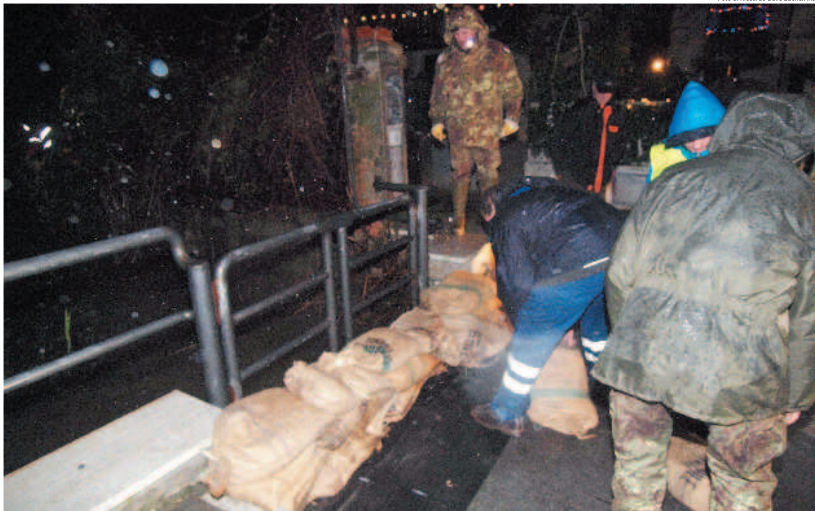
Il posizionamento dei sacchi di sabbia sull'argine del lago. I comuni di Viareggio, Camaiore e Massarosa stanno preparando i piani di evacuazione in previsione dell'ondata di maltempo
