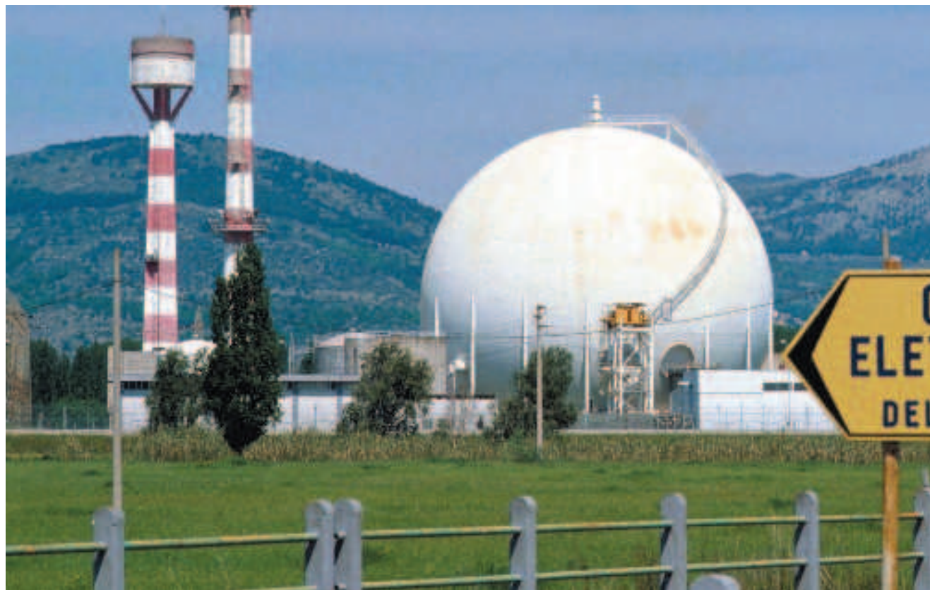
La ex centrale nucleare del Garigliano
