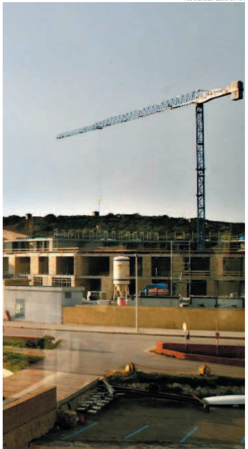
Cantieri lungo la costa dell'isola che ospiterà il G8 a luglio
