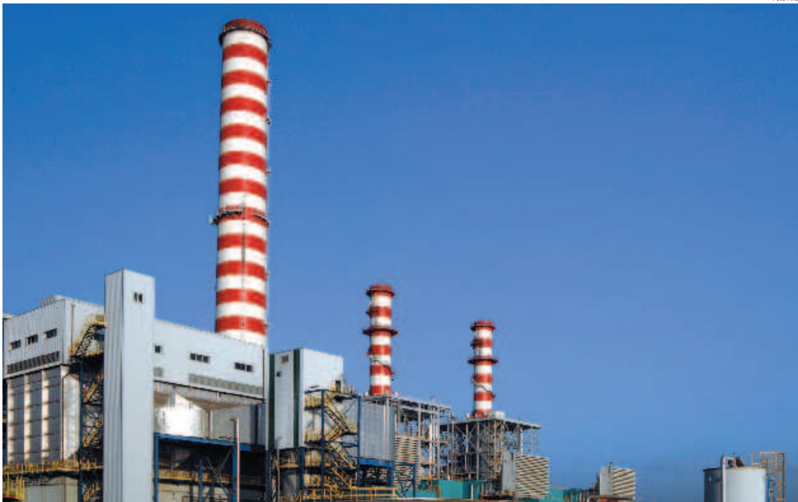
Una foto di archivio della centrale Enel di Torre Val Daliga
