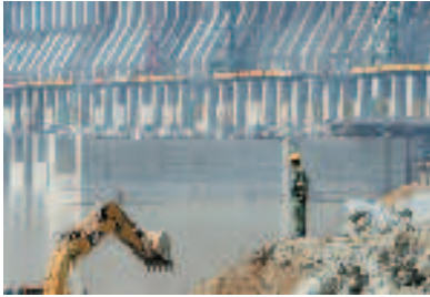
Il cantiere delle Tre Gole
