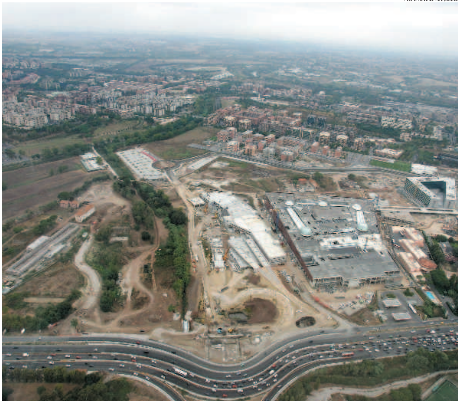
Centro commerciale in costruzione a Roma (foto d'archivio). Secondo l'urbanista «piccoli negozi andrebbero aiutati perché la loro presenza dà sicurezza e vivibilità»
