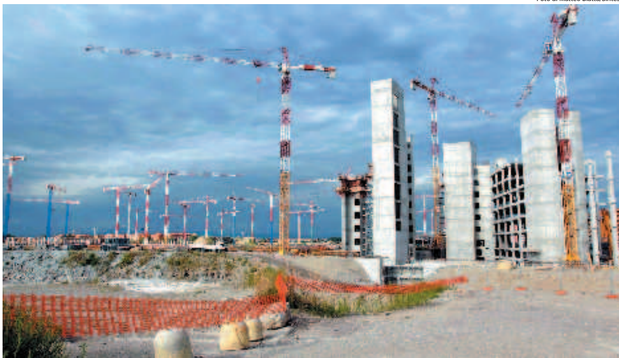
Milano Santa Giulia: i cantieri dove sorgerà il nuovo quartiere cantieri fiera expo
