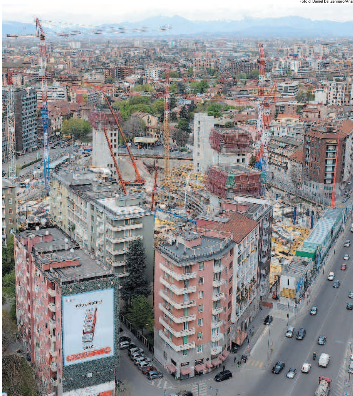
Una panoramica dall'alto del cantiere del Pirellone 2 a Milano
