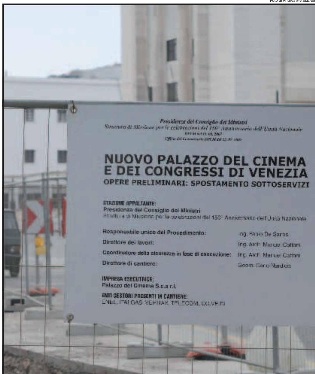
Il cartello Annunciati i lavori per il nuovo Palazzo del Cinema e dei congressi al Lido di Venezia
