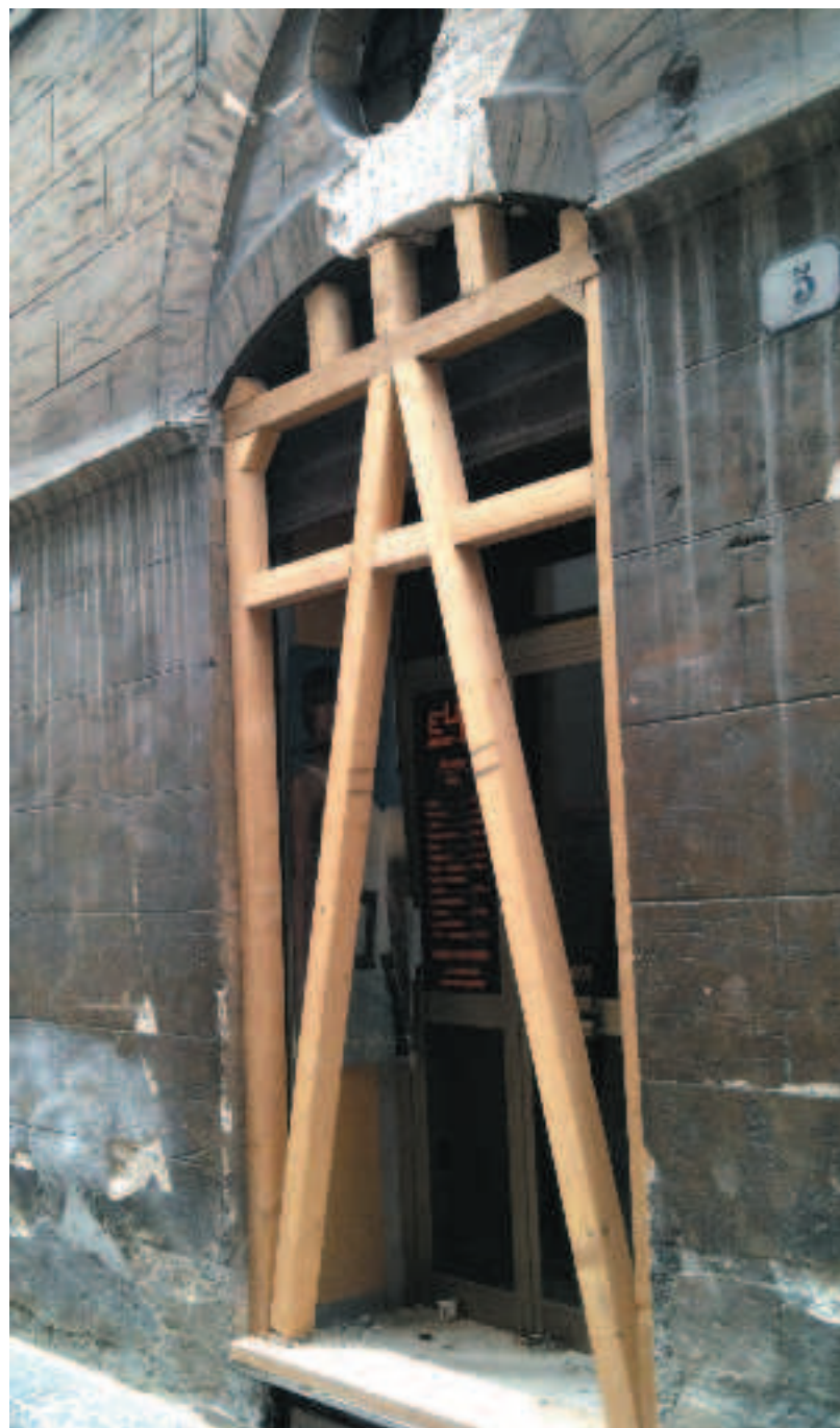
Un puntello provvisorio in un edificio del centro storico de L'Aquila
