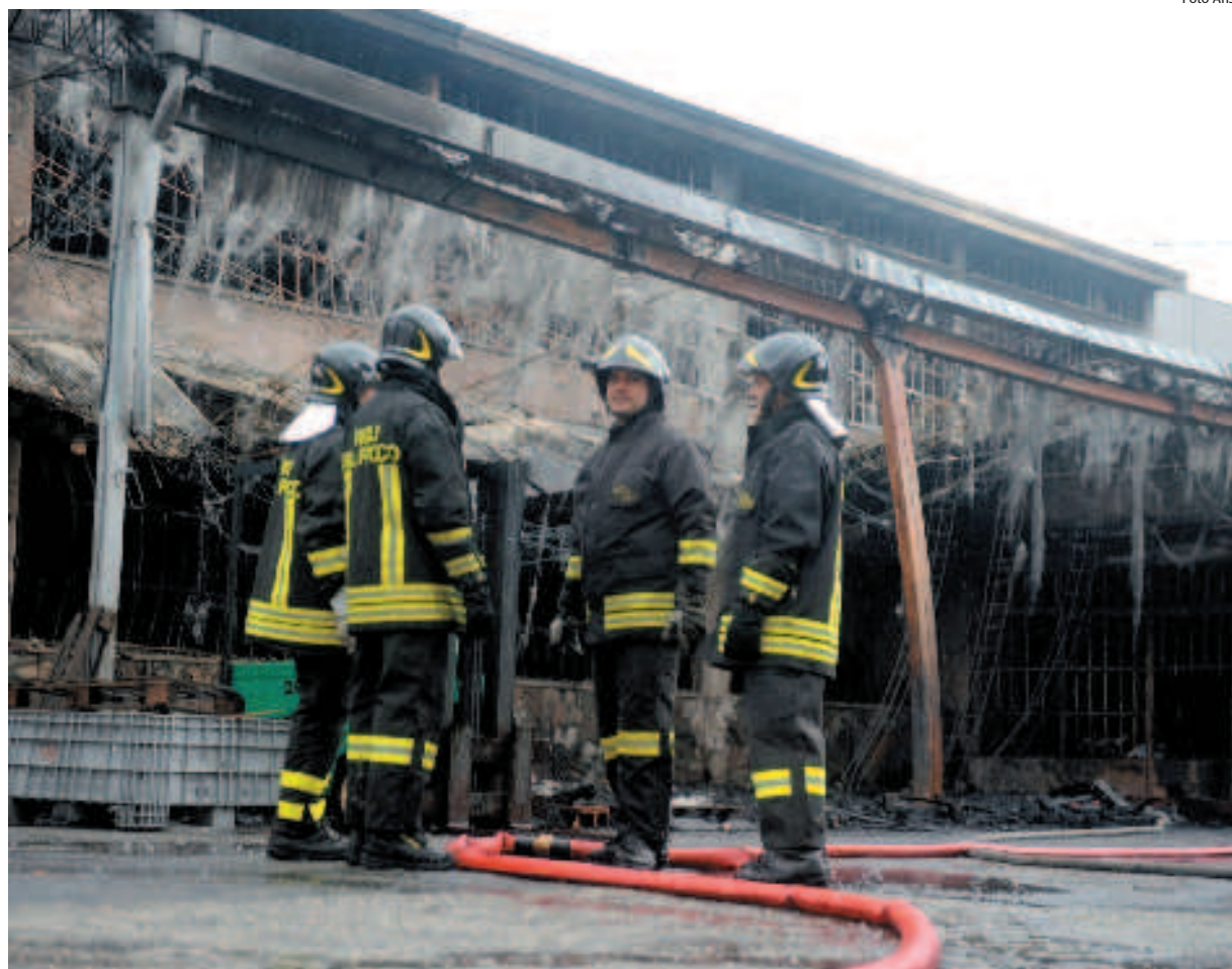
L'esterno della fabbrica di Muggiò in provincia di Milano dove sono morti carbonizzati i due operai cinesi
