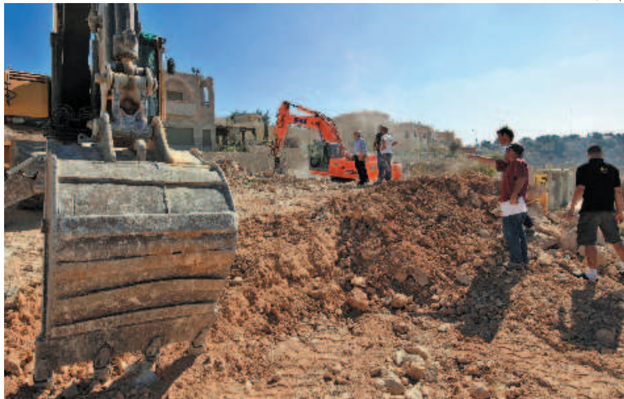
Le colonie Allo scadere della moratoria i lavori per ampliare gli insediamenti sono ripresi anche a Har Gilò
