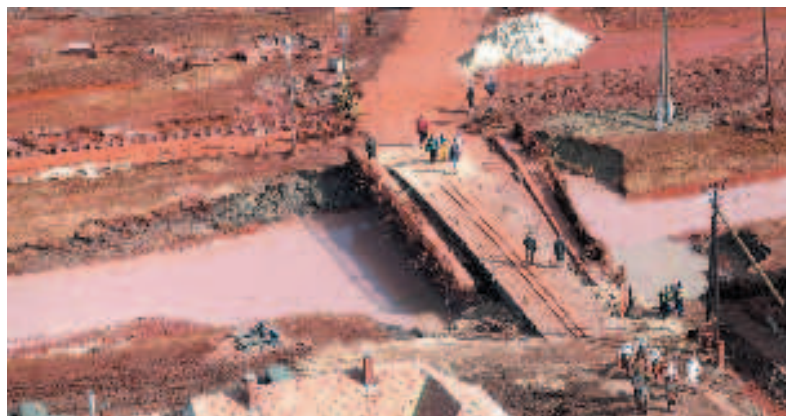
Un ponte provvisorio sul mare di fango
