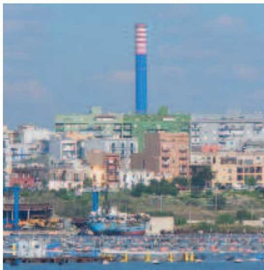
Il camino 312 dell'Ilva, da cui viene emessa la diossina
