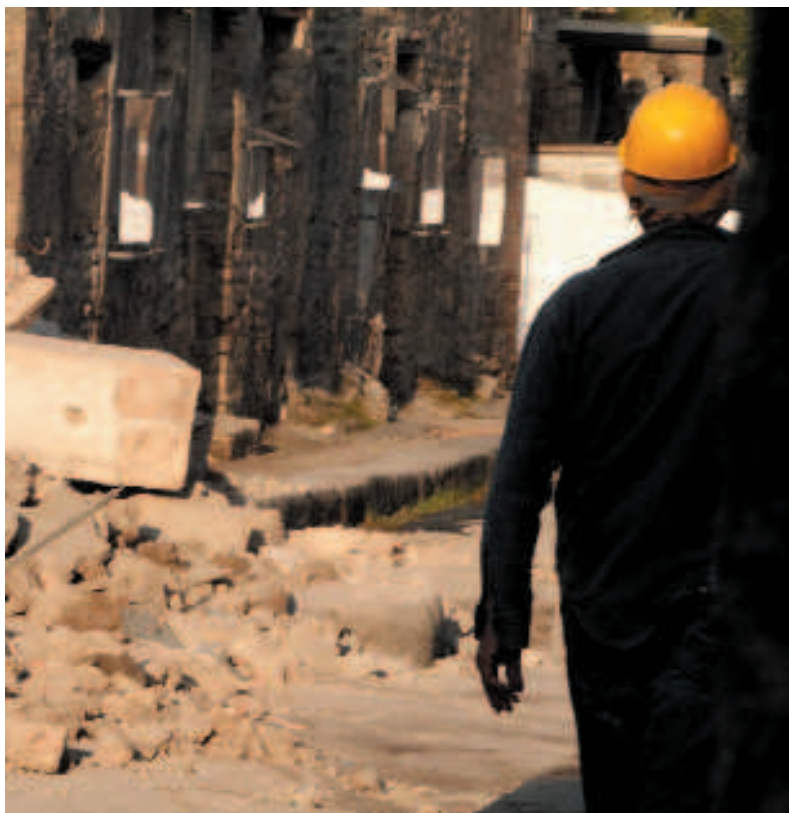
Macerie Un operaio nei pressi del crollo all'«armeria dei gladiatori» a Pompei
