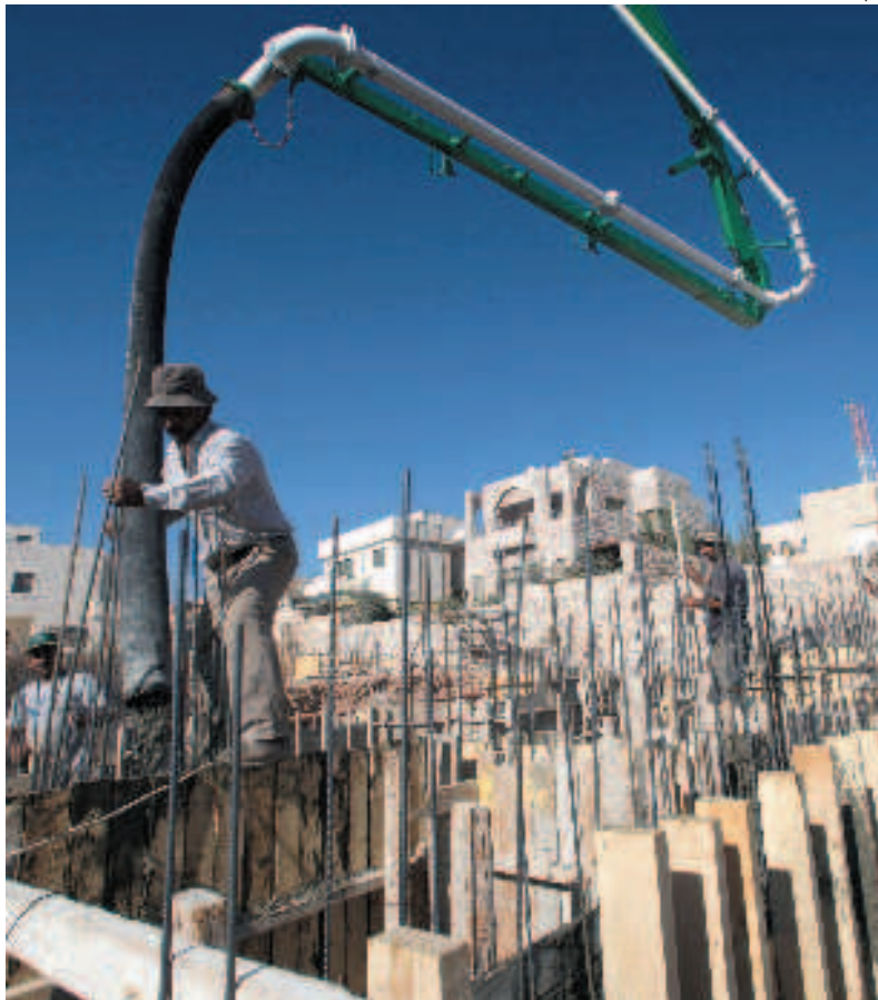
Lavori edili nell'insediamento ebraico di Har Gilo, subito a sud di Gerusalemme.
