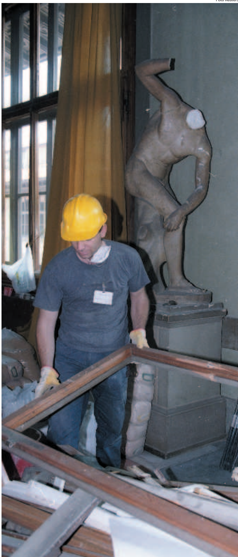
Un volontario impegnato nella ricostruzione dopo l'esplosione che danneggiò gli Uffici
