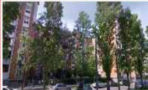
AUTOGESTIONE CA' GANDA VAL MAIRA SERVIZIO ENERGIA A MISURA
