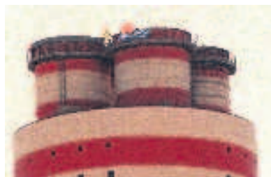
La centrale di Montalto di Castro
