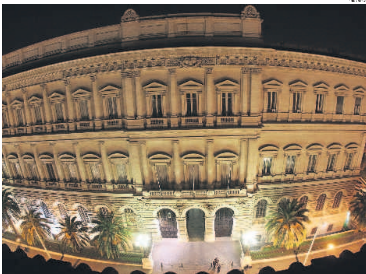
Palazzo Koch sede centrale della Banca d'Italia
