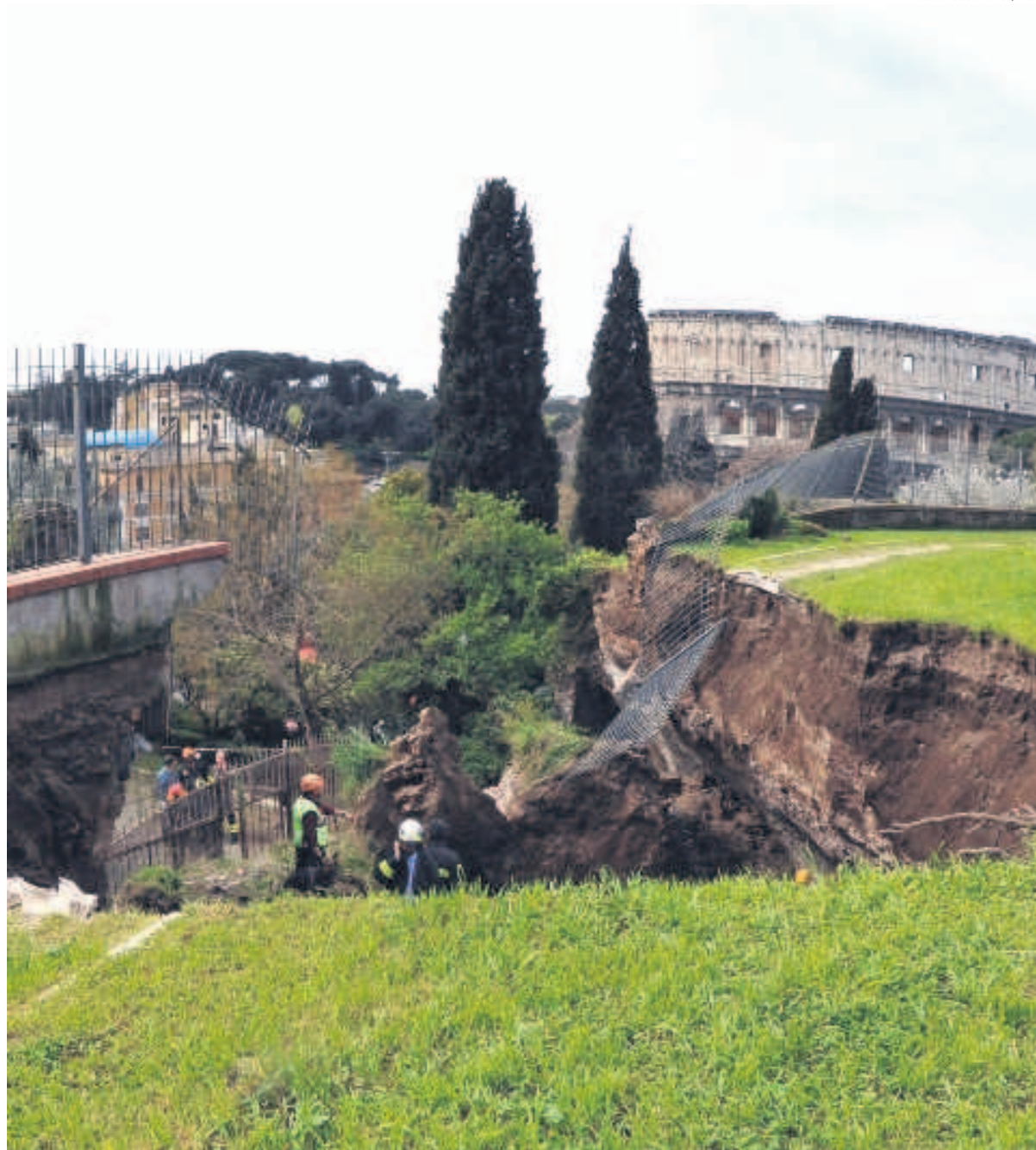
Povera Italia I vigili al lavoro presso il soffitto collassato della Domus Aurea
