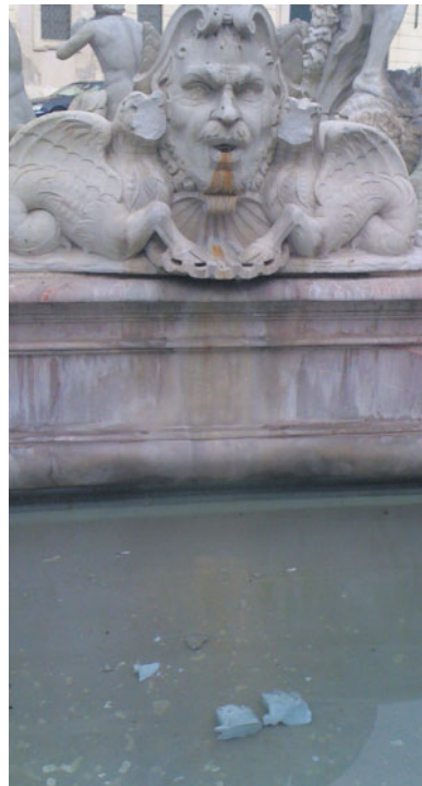
Il danneggiamento alla fontana del Moro
