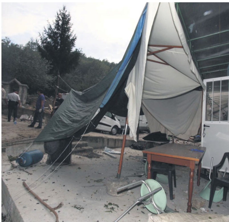
Le macerie dopo l'esplosione
