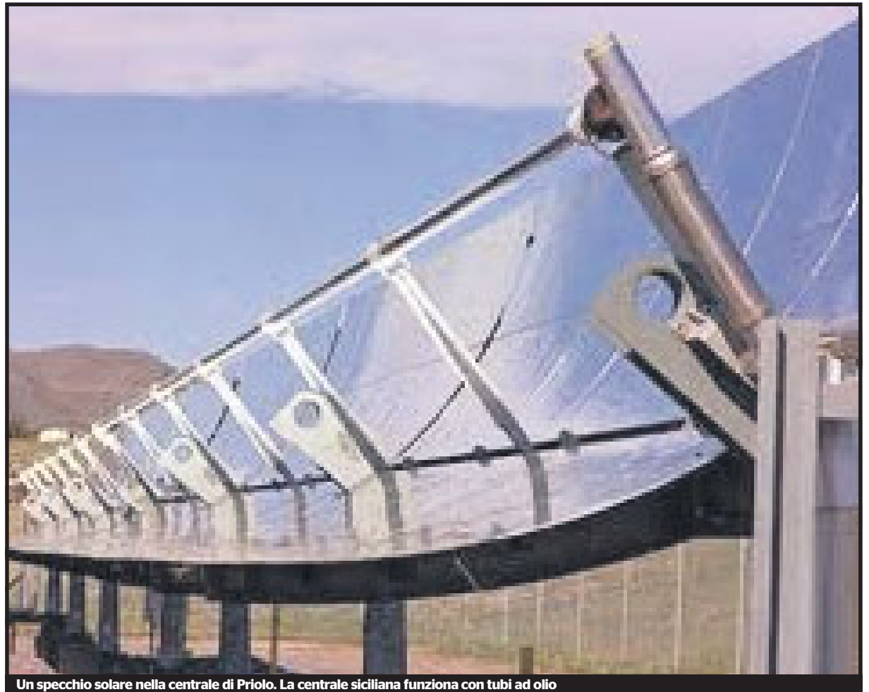
Un specchio solare nella centrale di Priolo. La centrale siciliana funziona con tubi ad olio
