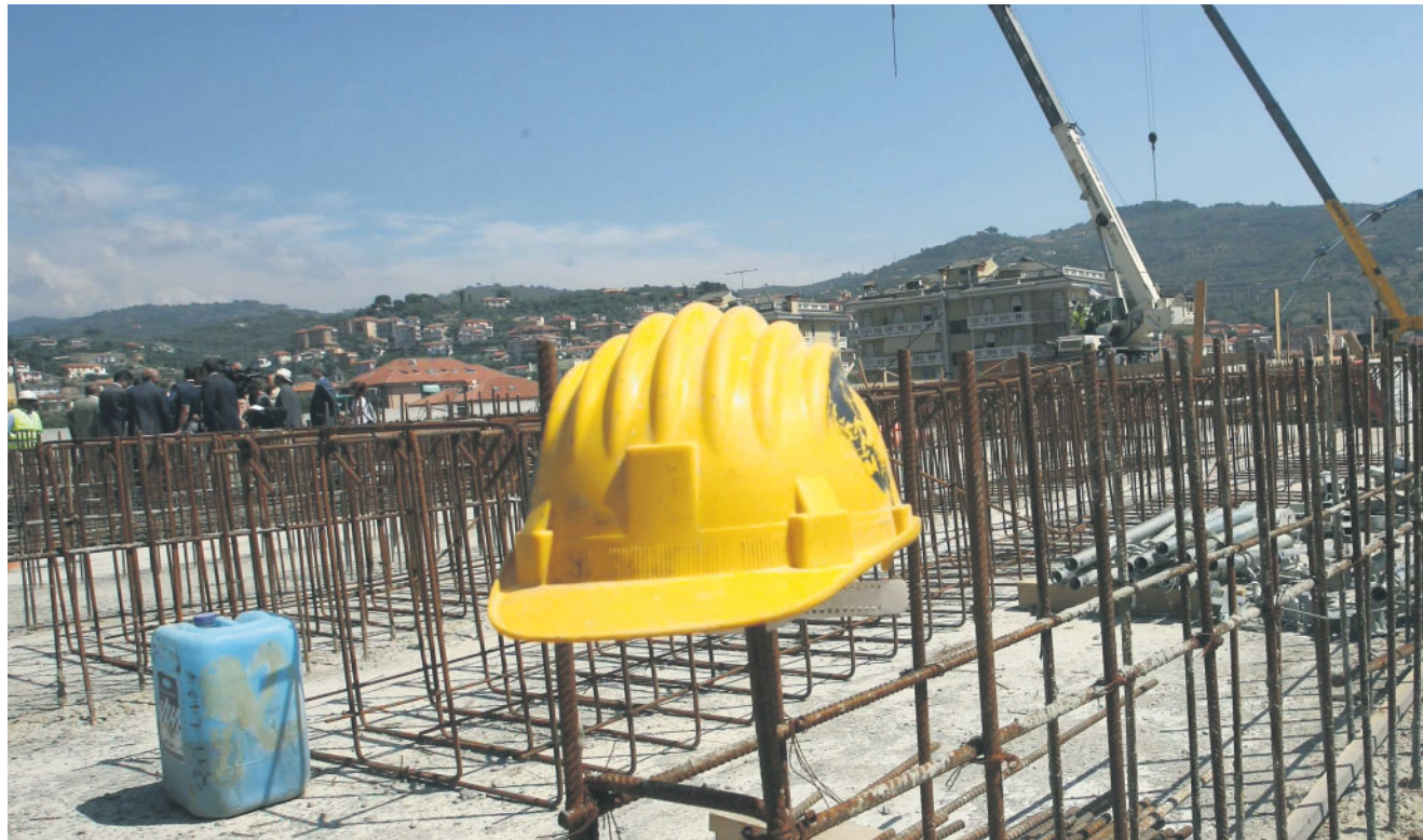
Un cantiere edile. Nel decreto sviluppo risputa il silenzio assenso per costruire
