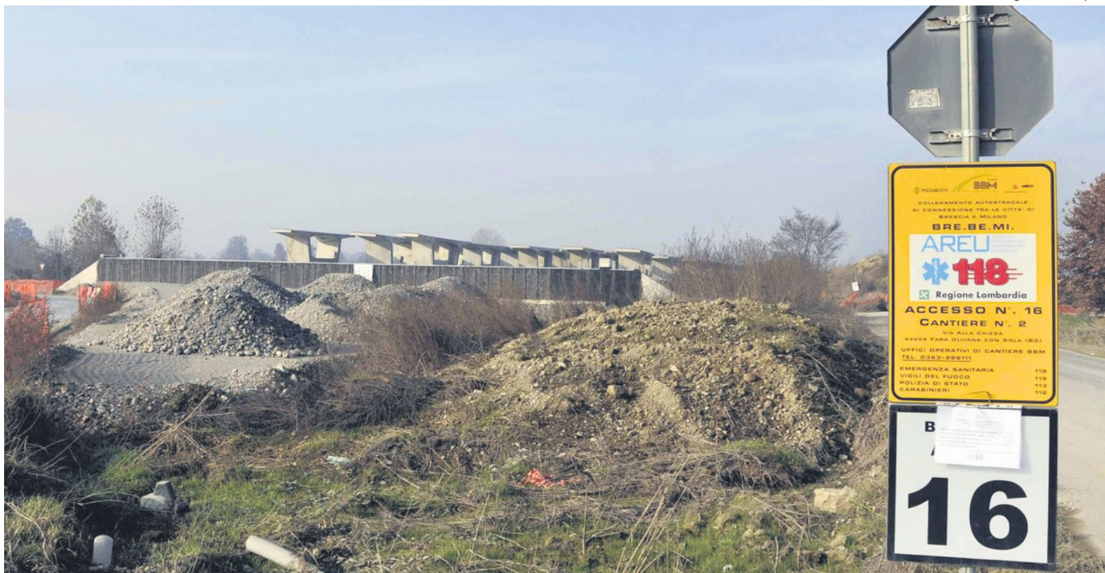
Il cantiere Bre.Be.Mi nei pressi di Fara Olivana. Secondo l'accusa anche questo era utilizzato come discarica
