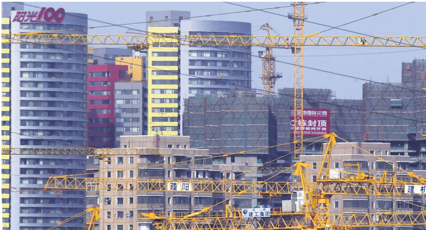
Grattacieli in costruzione in un quartiere satellite cinese
