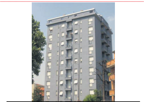
RISTRUTTURAZIONE EDIFICI SETTIMO MILANESE
