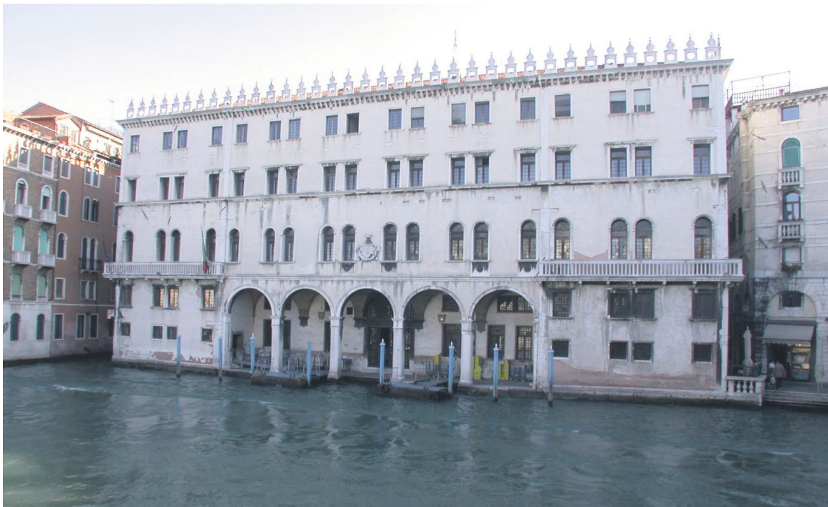
Il palazzo di Venezia chiamato Fontego dei Tedeschi al centro delle polemiche
