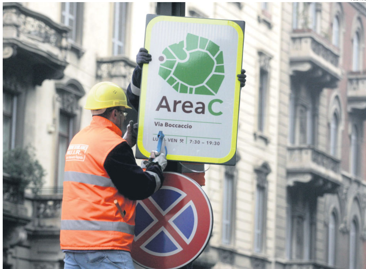
L'installazione dei primi cartelli stradali a Milano, con il logo della nuova Area a traffico limitato
