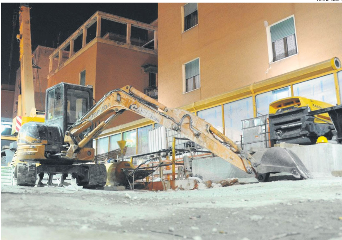
Il cantiere dove è avvenuto l'incidente sul lavoro alla metro C
