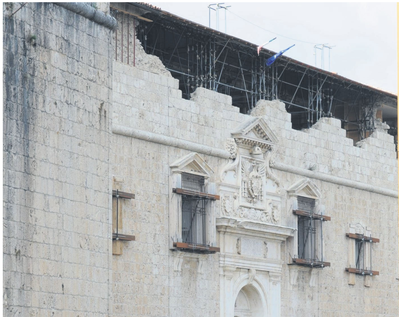
Un particolare della facciata anteriore del forte spagnolo a L'Aquila, danneggiata dal terremoto del 6 aprile 2009
