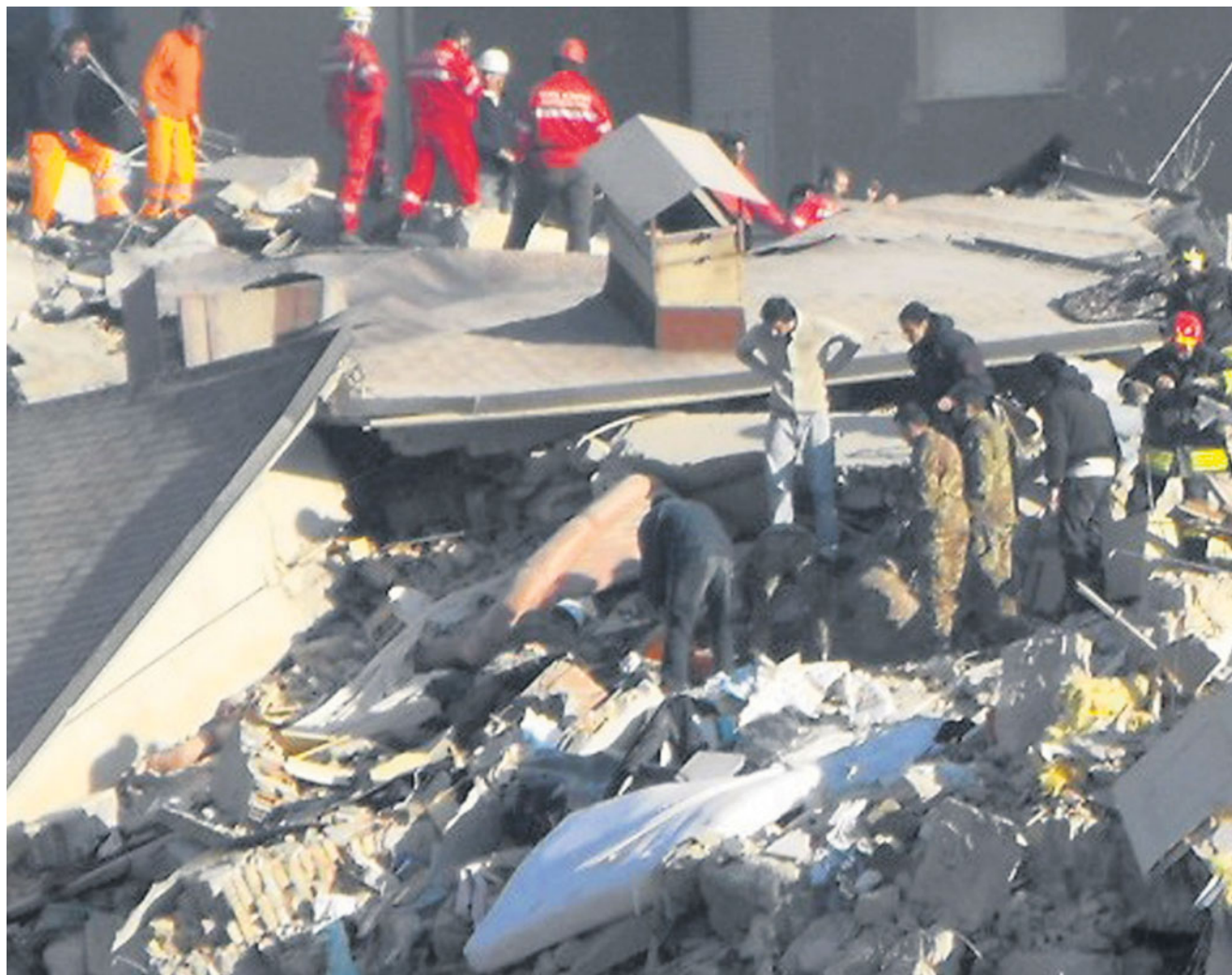
La Casa dello studente in via XX Settembre a L'Aquila, completamente distrutta dal sisma
