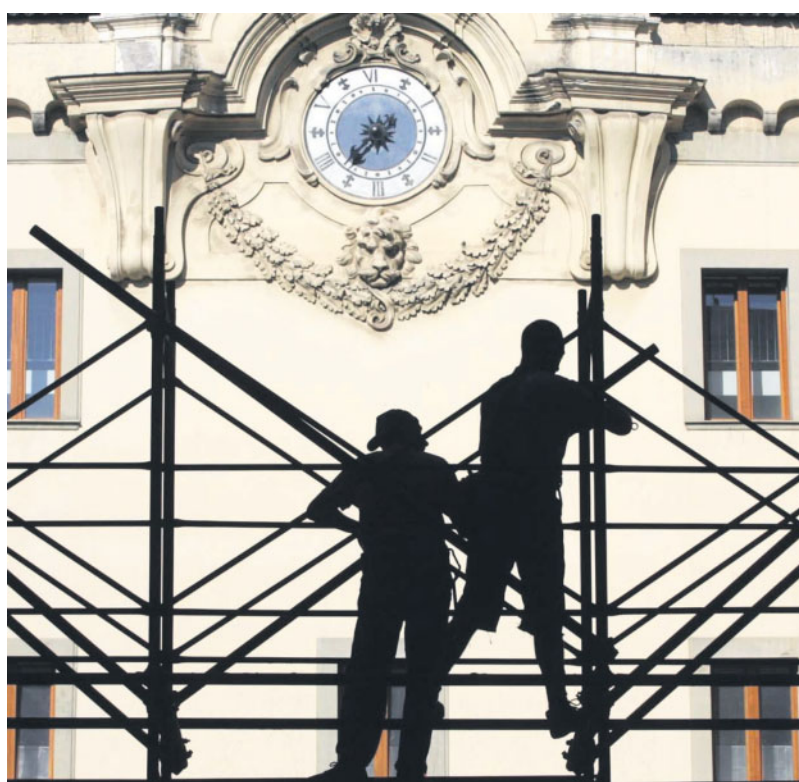
Operai al lavoro su un ponteggio
