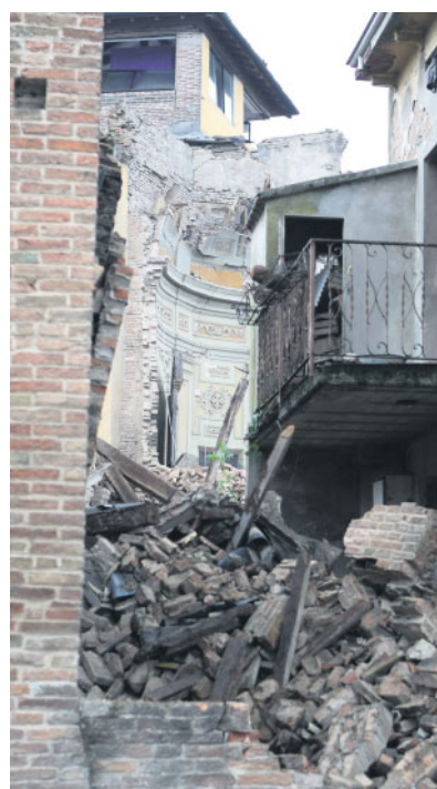
La chiesa di S. Felice sul Panaro FOTO ANSA
