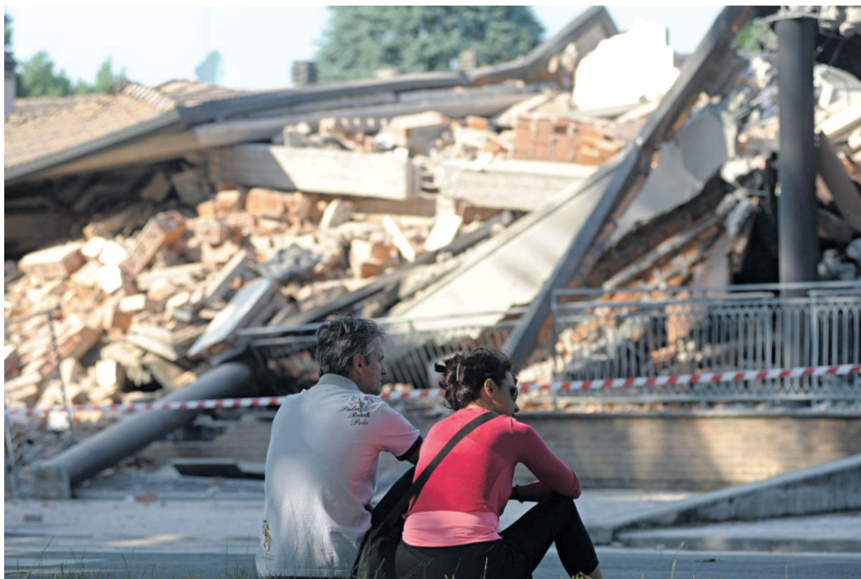
Due persone di fronte a un edificio distrutto dalle scosse di terremoto a Cavezzo, Modena. FOTO DI MAURIZIO DEGLI'INNOCENTI/ANSA
