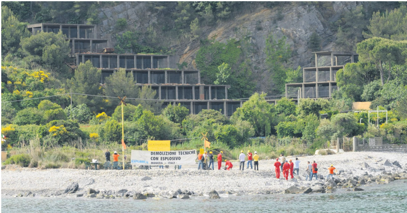
La demolizione il 22 maggio 2009 dello "Scheletrone" sull'Isola Palmaria, considerato dagli ambientalisti la costruzione più brutta d'Italia FOTO DI LUCA ZENNARO/ANSA
