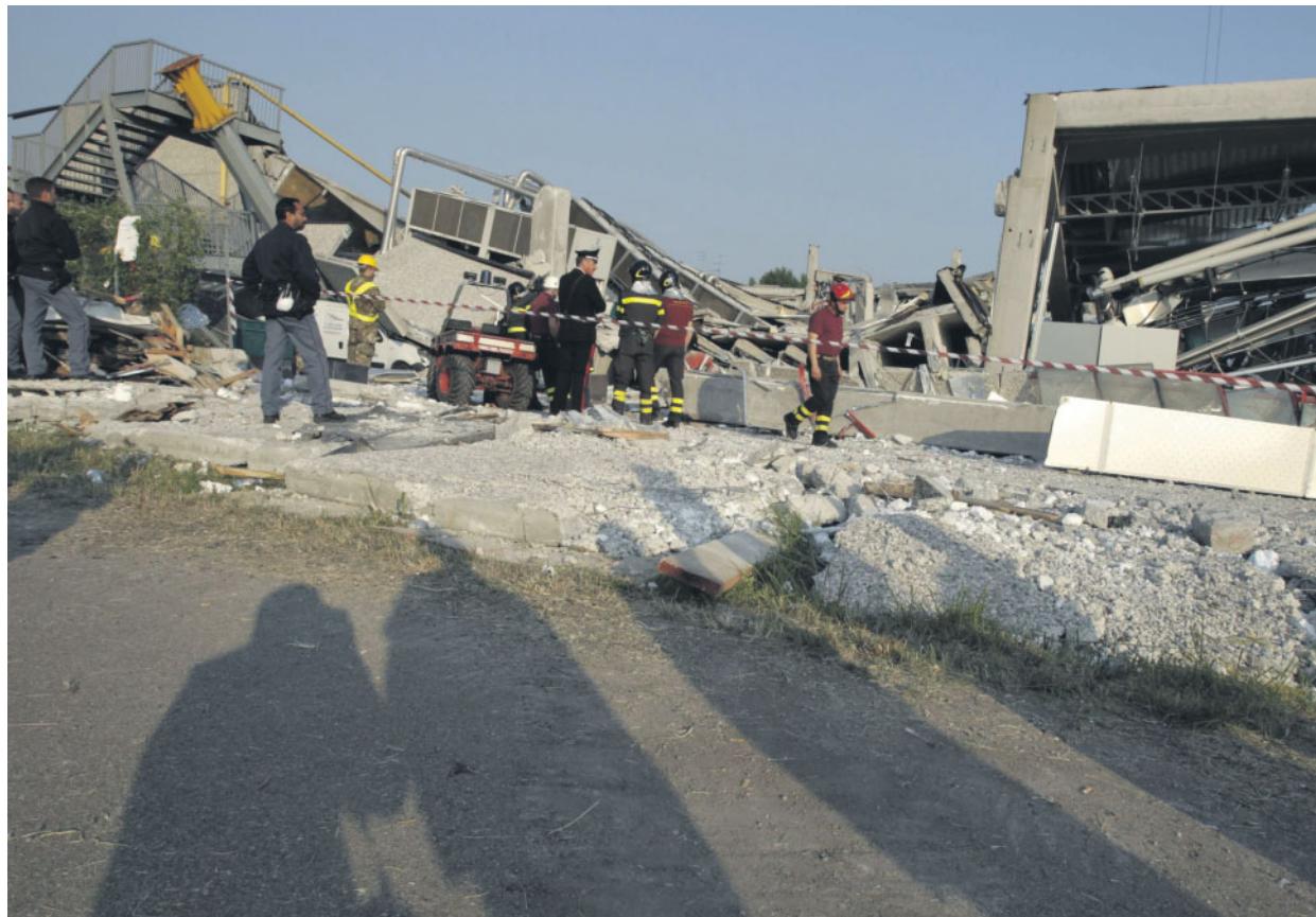
Un capannone a Medolla crollato per il terremoto FOTO MATTEO CIAMBELLI-MASSIMO SESTINI/ANSA
