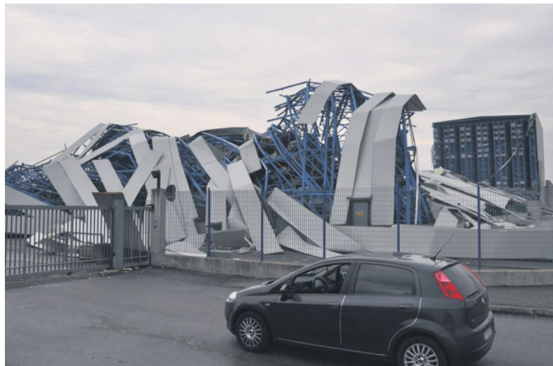
Uno dei capannoni crollati a Sant'Agostino (Ferrara) FOTO ANSA
