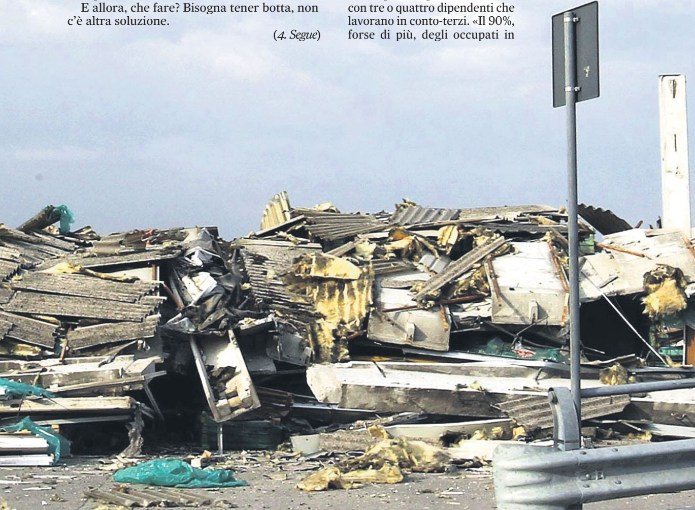
Il capannone crollato della Sant'Agostino. Sono morti due operai: Nicola Cavicchi e Leonardo Ansaloni. FOTO ANSA/SERENA CAMPANINI
