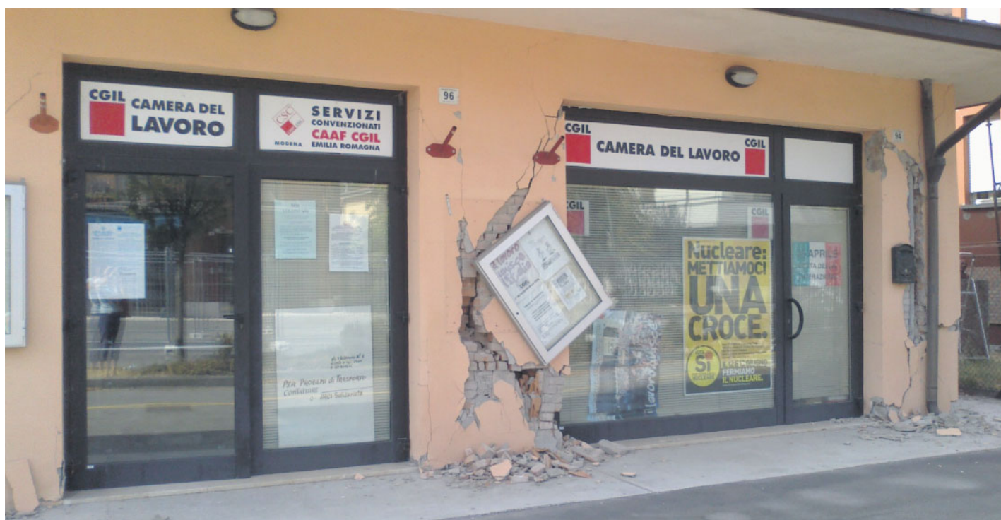
Carpi, la sede della Camera del lavoro dopo il terremoto di maggio, è stata riparata a tempo di record
