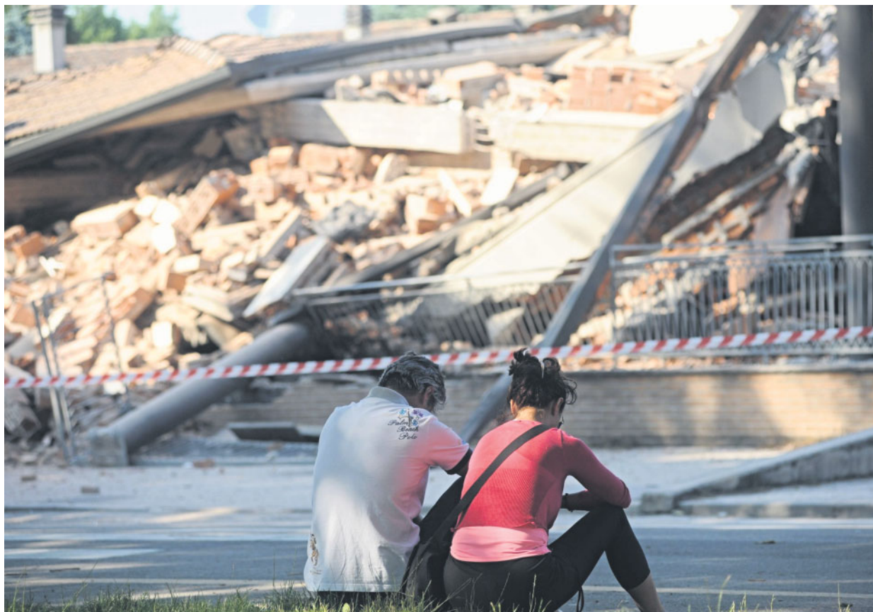
Due persone di fronte a un edificio danneggiato dalle scosse di terremoto in Emilia Romagna, a Cavezzo (Modena), 29 maggio 2012. FOTO ANSA
