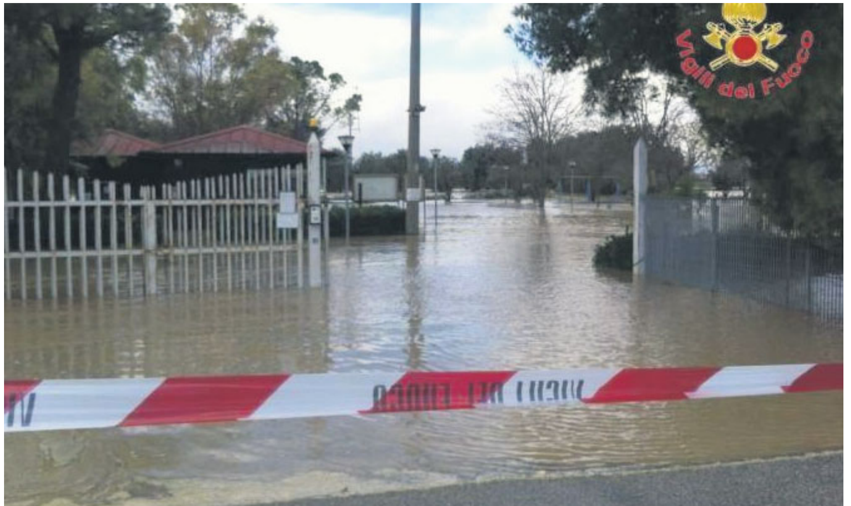
L'ingresso dell'area degli scavi archeologici dopo l'esondazione del fiume Crati
